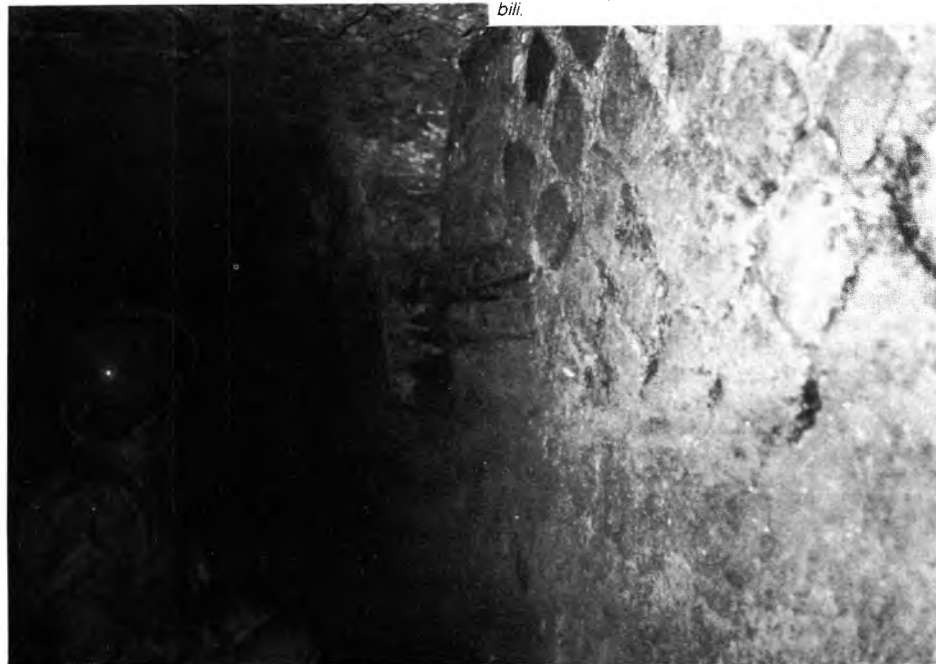
Rinforzo in "opus reticulatum" all'incontro di strati friabili.
